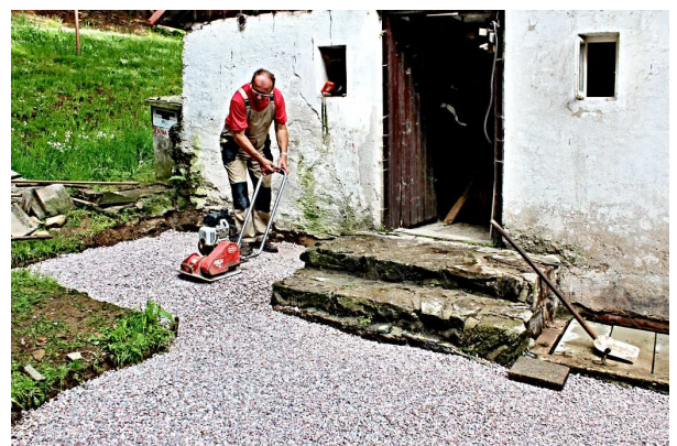
Štěrková vrstva byla řádně zhutněna vibrátorem.
