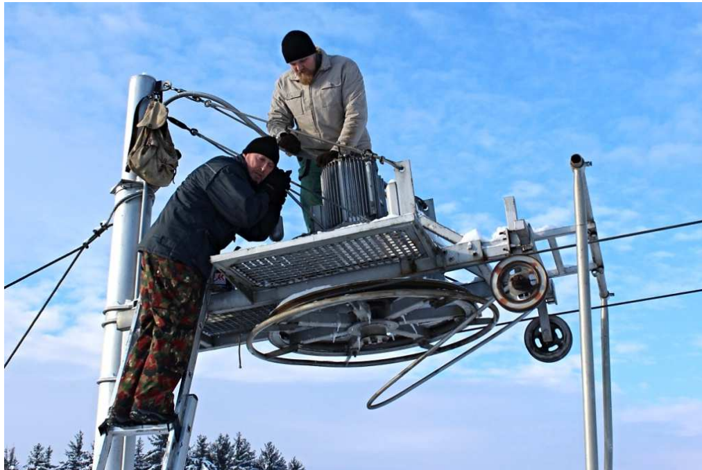
Václav Šeps a Dan Patka při opravě ložiska motoru.
