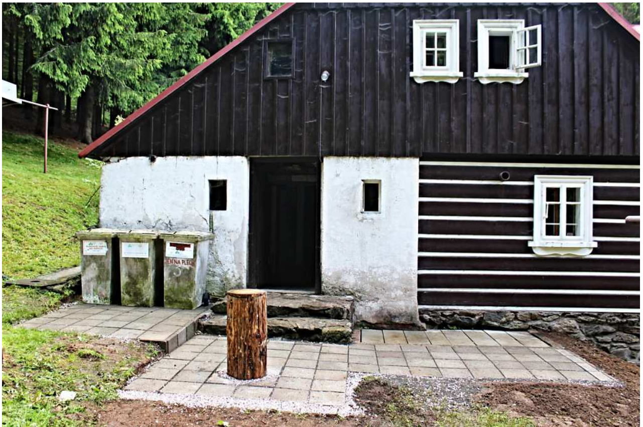
A takto nyní vypadá obnovená dlažba.
