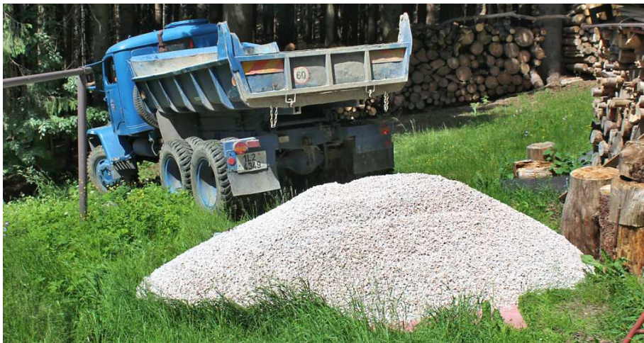
Pod dlažbu se vešel celý nákladák drobného štěrku.
