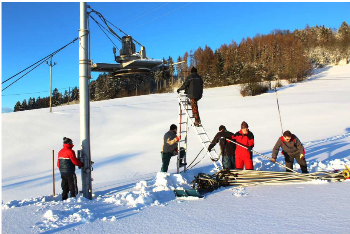
Montáž teleskopických tyčí (kotviček) na tažné lano vleku.
