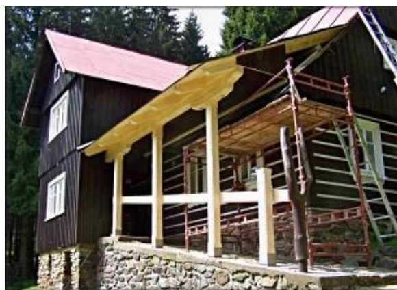
Tesařské práce jsou dokončené.
