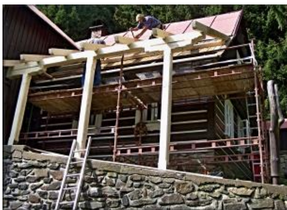
Dokončování dřevěné konstrukce.
