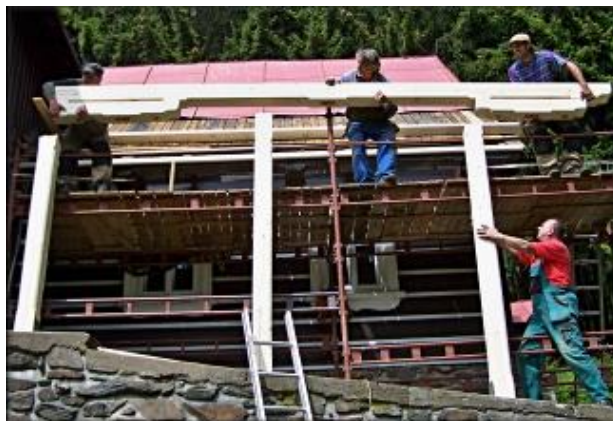
Montáž dřevěné konstrukce zastřešení.
