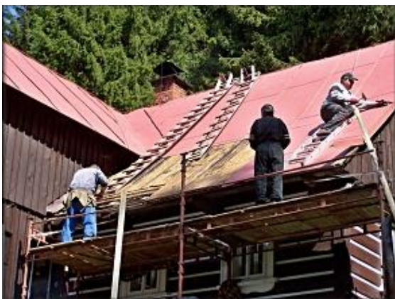
Rozkrývání plechové krytiny střechy.
